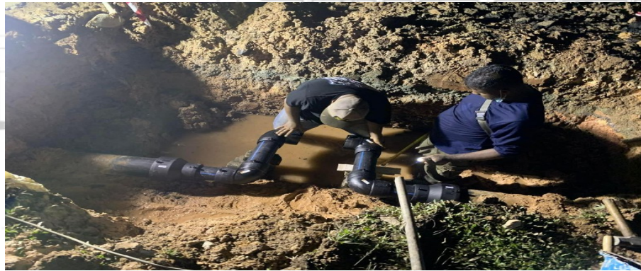
HDPE Pipe Repair & Installation @ Bertam Sekolah Menengah
